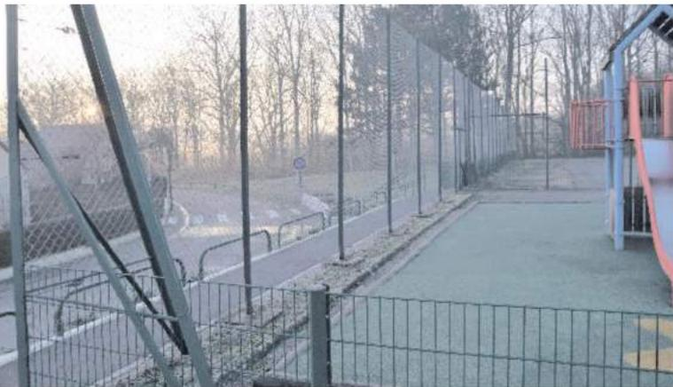
La clôture du terrain de sport a été réparée par l'entreprise Pasquereau (changement de poteaux et panneaux détériorés) pour un coût de 953.50 € HT. Suite à ces travaux, terminés mi-novembre, les services techniques ont installé un nouveau filet en périphérie du terrain, en hauteur (fourniture filet et crochets : 531.90 € HT).
